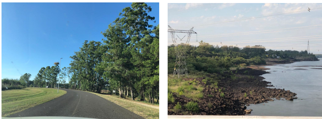
Figura 36. Ruta en dirección al ingreso de la Central Hidroeléctrica (izq.) y vista aguas abajo desde la Central, lado uruguayo (der.).
