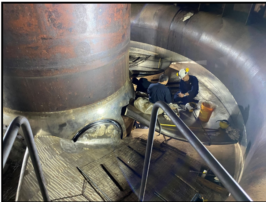
Figura 57 - Labores de mantenimiento de la turbina Kaplan correspondiente a la Unidad # 9
