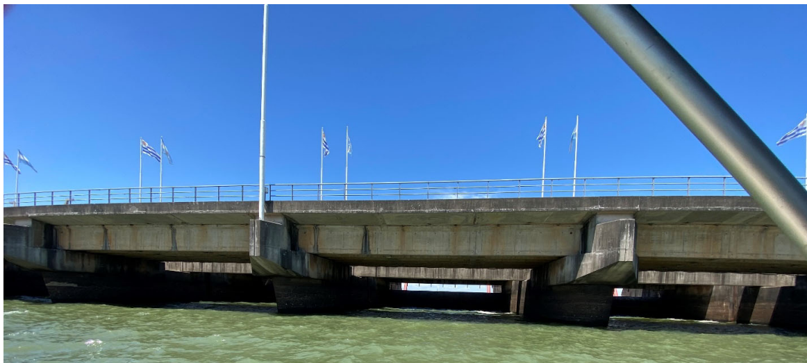
Figura 50 - Vista de los vanos de compuertas
