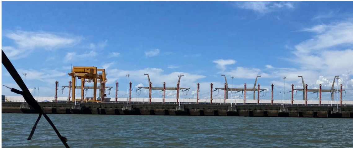
Figura 49 - Vista general de la presa desde aguas arriba
