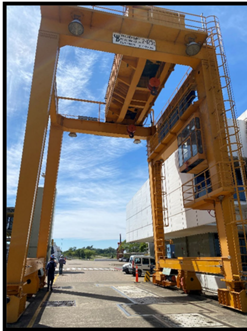
Figura 3 – Grúa Pórtico del CHSG
