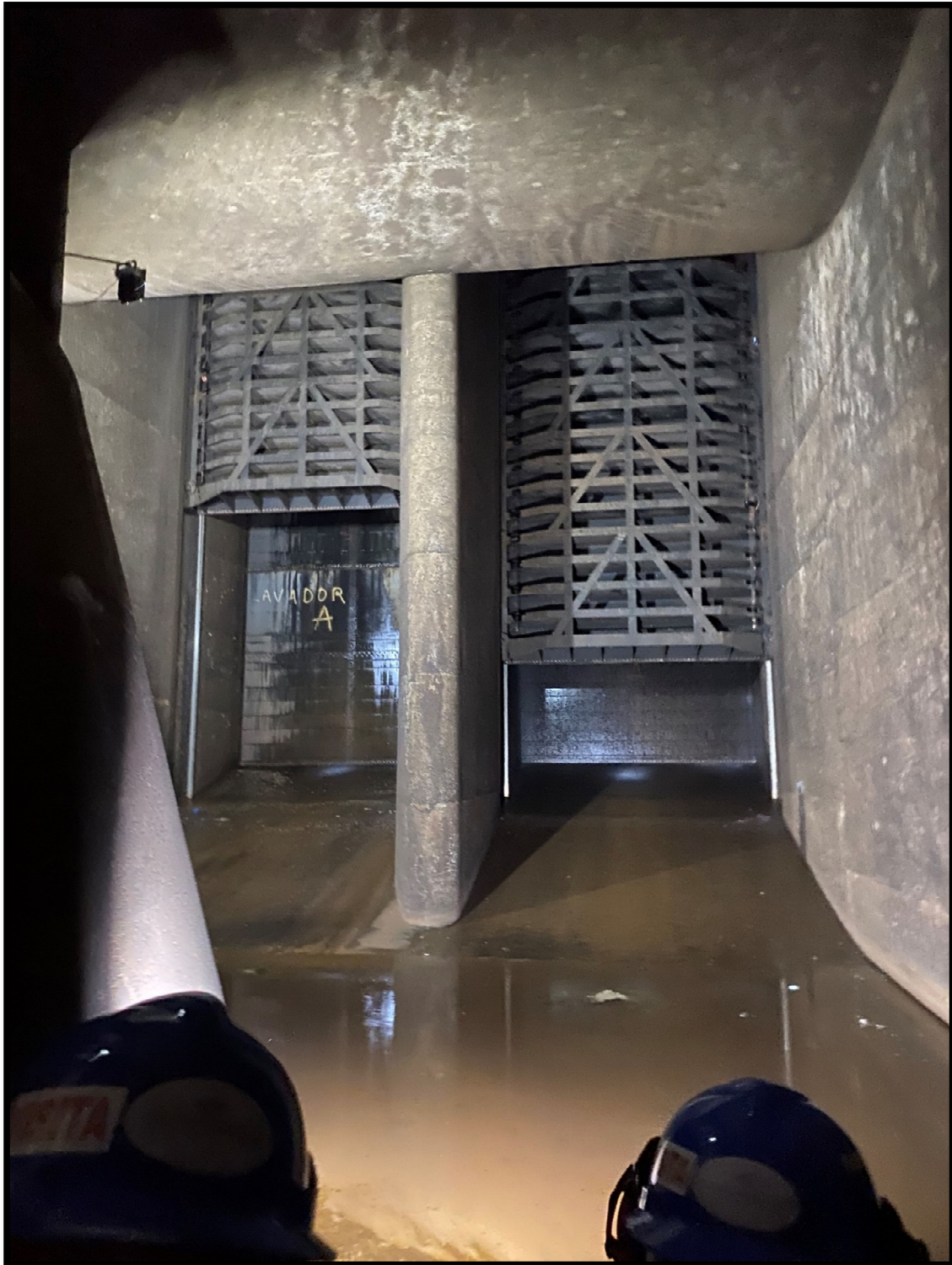
Figura 56 - Compuertas y paredes del caracol de acceso a la turbina de la Unidad # 9
