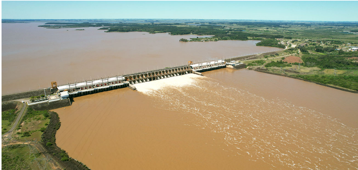
Figura 52 - Funcionamiento de las compuertas de vertimiento
