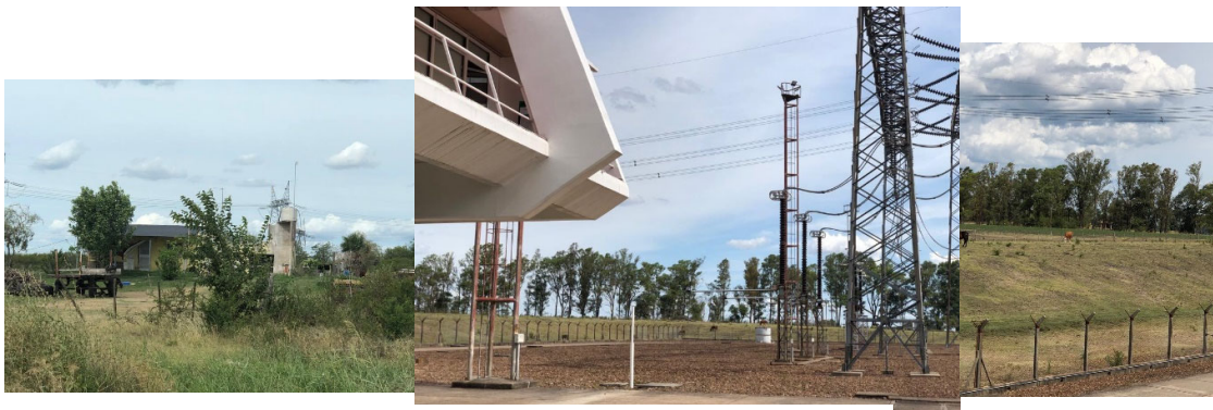
Figura 37. Entorno subestación Colonia Elía (Argentina)
